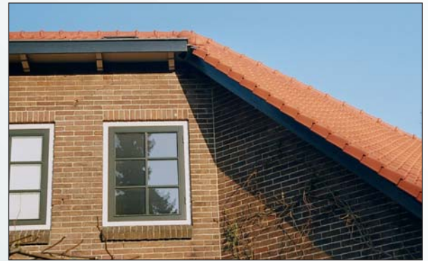
3. De schaduw van een rechte dakgoot vertoont op de overgang van de ene muur naar de andere een knik. Dit is hetzelfde effect dat het niet-parallel zijn van de zonnebeeldjes in figuur 2 veroorzaakt. (Foto G.P. Können; Soest)
